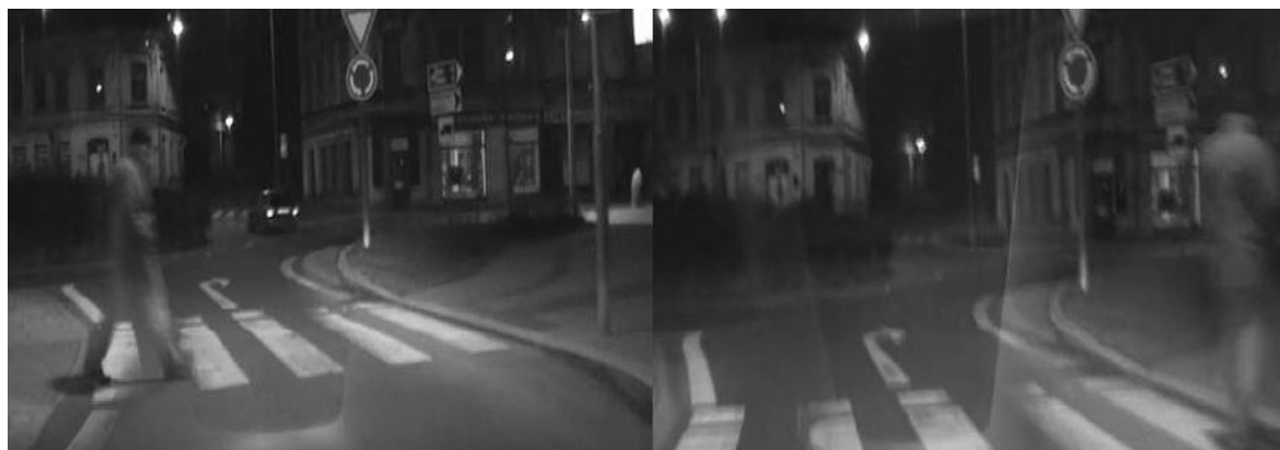
Obr 4. Přečhod osvětlený přečhod z obou stran, kruhový objezd, 2.x 250 W
